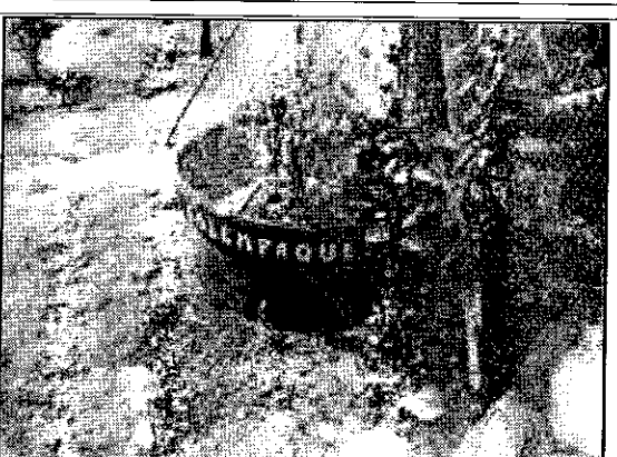
Fotografía No. 4. Tanque séptico que no prestó servicio alguno en el sistema de tratamiento.
