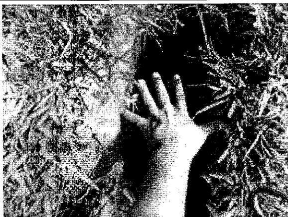
Fotografía No 3. Excavaciones acueducto vereda La Cachiza. Nótese que el ancho de la excavación no supera el ancho de la mano, y que el material es material común.
