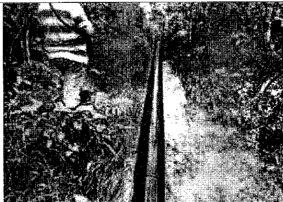
Fotografía No 3. Tubería expuesta, producto de la flotación por nivel freático.
