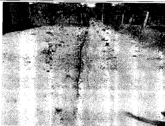
Fotografía No 1. Excavaciones del acueducto Cerritos erosionadas por la escorrentía superficial. Nótese tipo de material y ancho de excavaciones.
