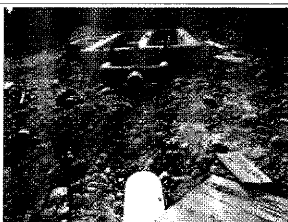
Fotografía No 2. Desarenador, pendiente conexión de aducción.
