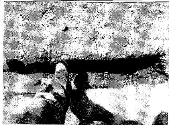
Fotografía No 2. Excavaciones de acueducto Cerrito. Nótese que el ancho de la excavación no supera el ancho de la bota, 30 cm.
