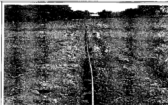
Fotografía No 2. Fuente: Registro fotográfico suministrado por interventoría. Obsérvese ausencia de cama de arena y dimensiones de excavaciones con relación al diámetro de la tubería = 2,54 cm.
