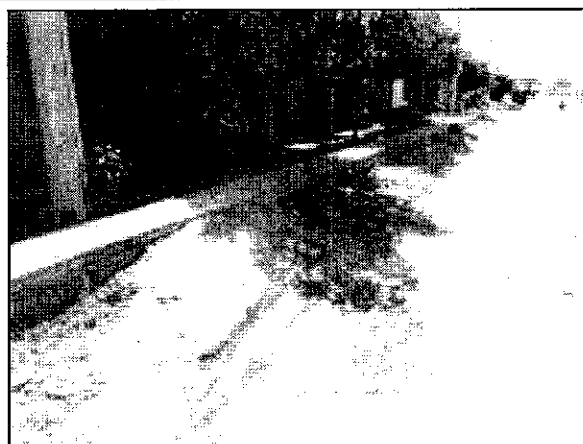
Fotografía No 1. Obsérvese la diferencia de altura del canal con respecto al terreno, el agua no puede ingresar al sumidero.
