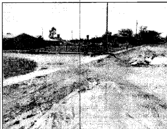
Fotografía No 2. Canal a nivel del terreno, por consiguiente los sumideros se encuentran tapados y no puede ingresar el agua lluvia.
